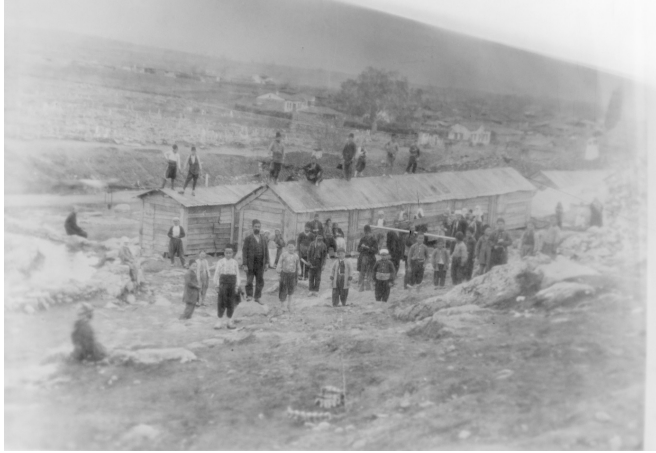
Fotoğraf 2: 1898 Depremi sonrası Balıkesir Aziziye Mahallesinde depremzedeler için kurulan barakalar. (Balıkesir Kent Arşivi Koleksiyonu)
