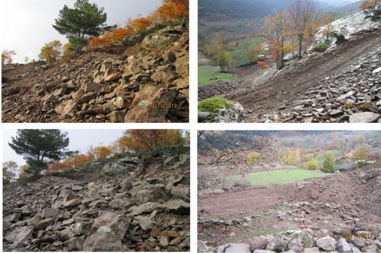
Fotoğraf 10. Kaya Düşmesi Islah Çalışmaları Sonrası Görünüm
