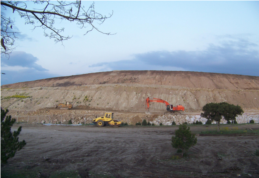
ekil 20. Son havuz setinin mansap k,sm,n,n desteklenmesi amac,yla yapı,lan çal, malar
