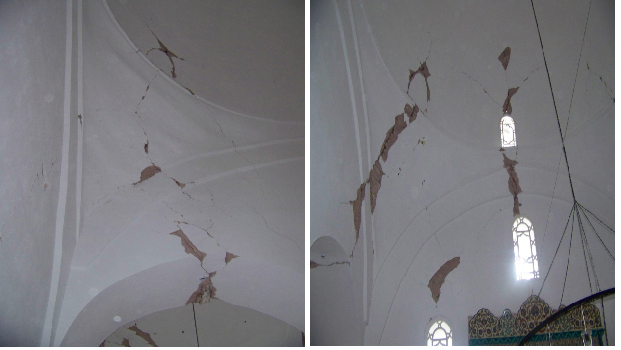
ekil 15. Nasuha a Camii'ndeki kesme çatlaklar, ve dökülmeler
