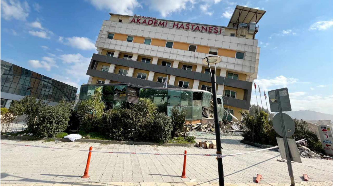
Hatay Merkez Akademi Hastanesi Binası
