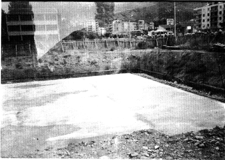
D- 1 Haziran 1992 - Manisa Öğretmenevi Zemin Islahı sonrası 10 cm. lik Grobeton evresi.
