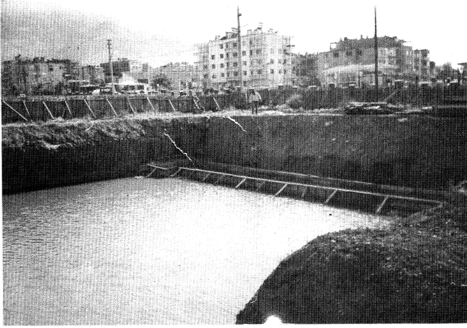
A- TMart 1992 - Manisa ÖğretmenevL Zemin İslahı öncesij isiah yapılmadan temel atma çabası başarısızlıkla sonuçlandı. Kireçtaşı stabilizasyonu ile zemin kurutuldu.
