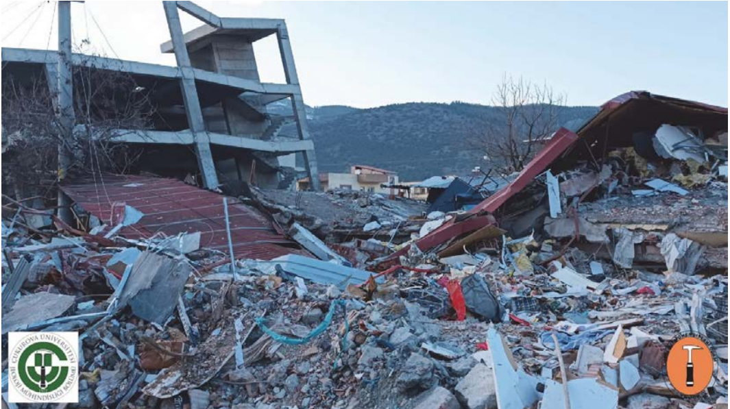
Akçakoyunlu Caddesinde yüzey yırtılması üzerinde yıkım
