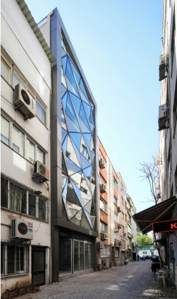
2017 Yılında Tamamlanan İzmir Şube Binası
