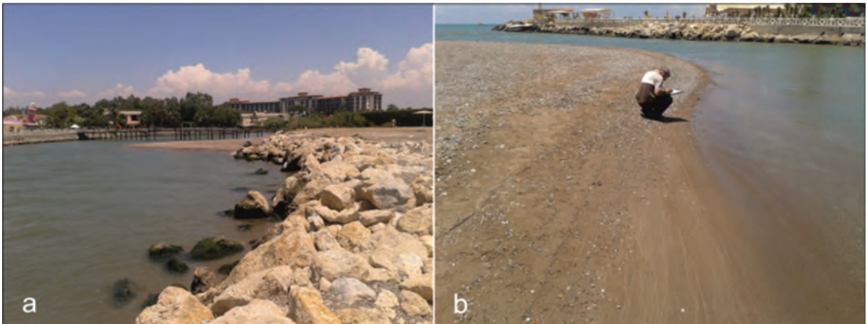
Şekil 3. Acısu Dere ağzının güneyden görünüşü (a), Kuzeyden görünüşü (b)
