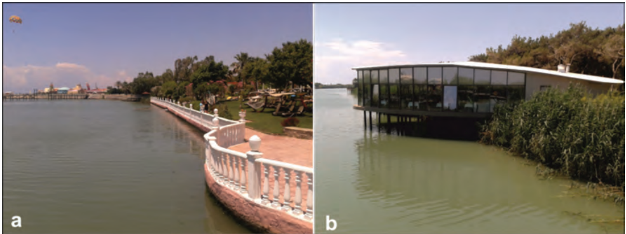
Şekil 5. Acısu Deresi sağ sahilinde doğal ortama yapılan sınırlamalar (a), sol sahilinde yapılan sınırlamalar
