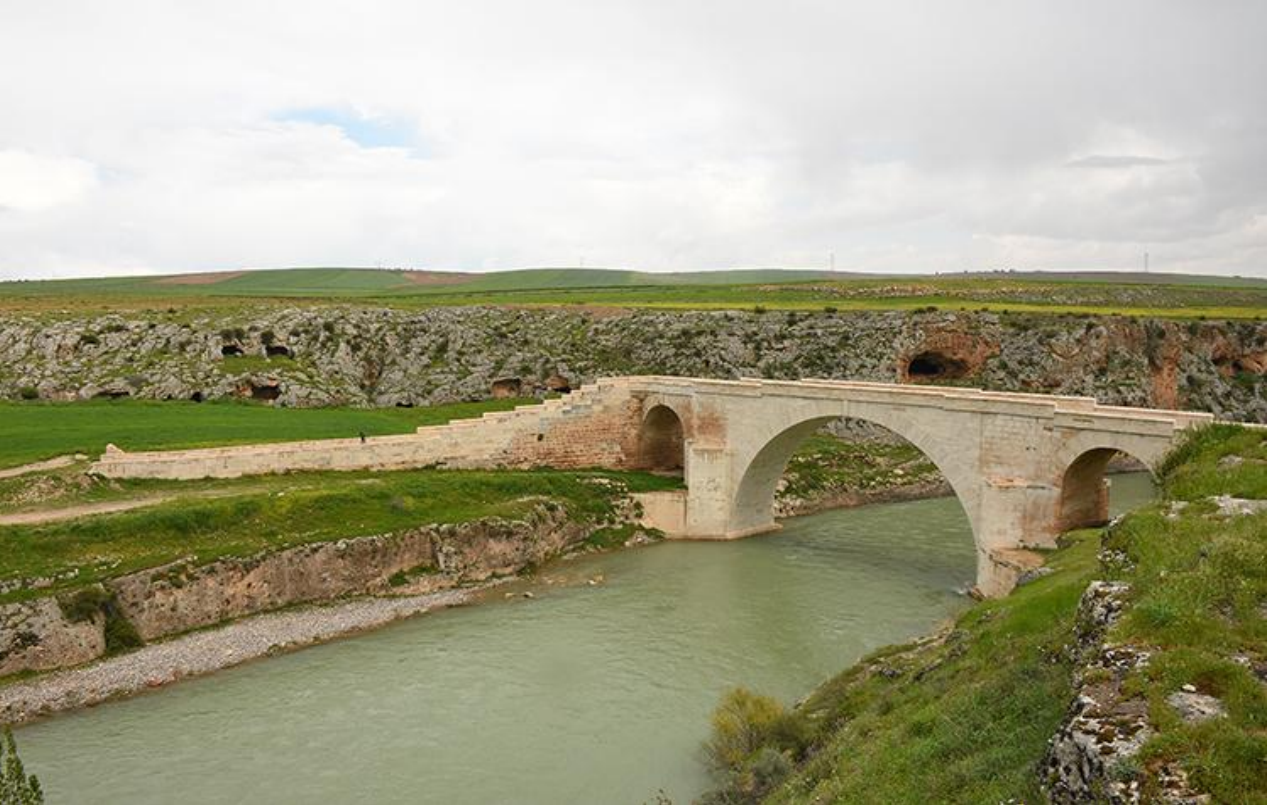
Şekil 32. Kızılın Köprüsü'nün restorasyon öncesi ve sonrası görünüşleri (Bilgin-Altınöz ve Şahin-Güçhan 2018).
