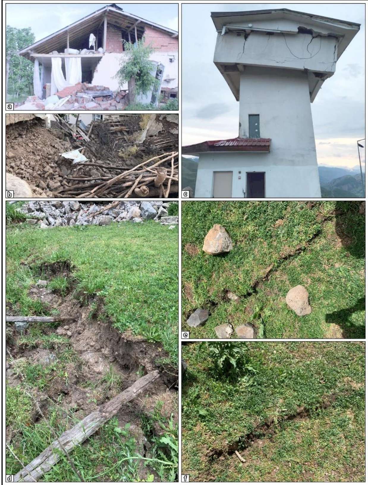
Şekil 1. Deprem binanın ve zemin üzerindeki yerel etkileri ve VII şiddetindeki hasarı gösteren arazi görüntüleri.
