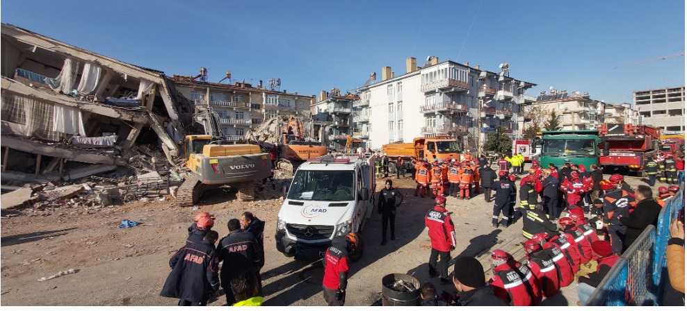
Şekil 23. Elazığ merkez Sürsürü Mahallesinde çöken binadaki enkaz kaldırma çalışmasına ait görüntü.
