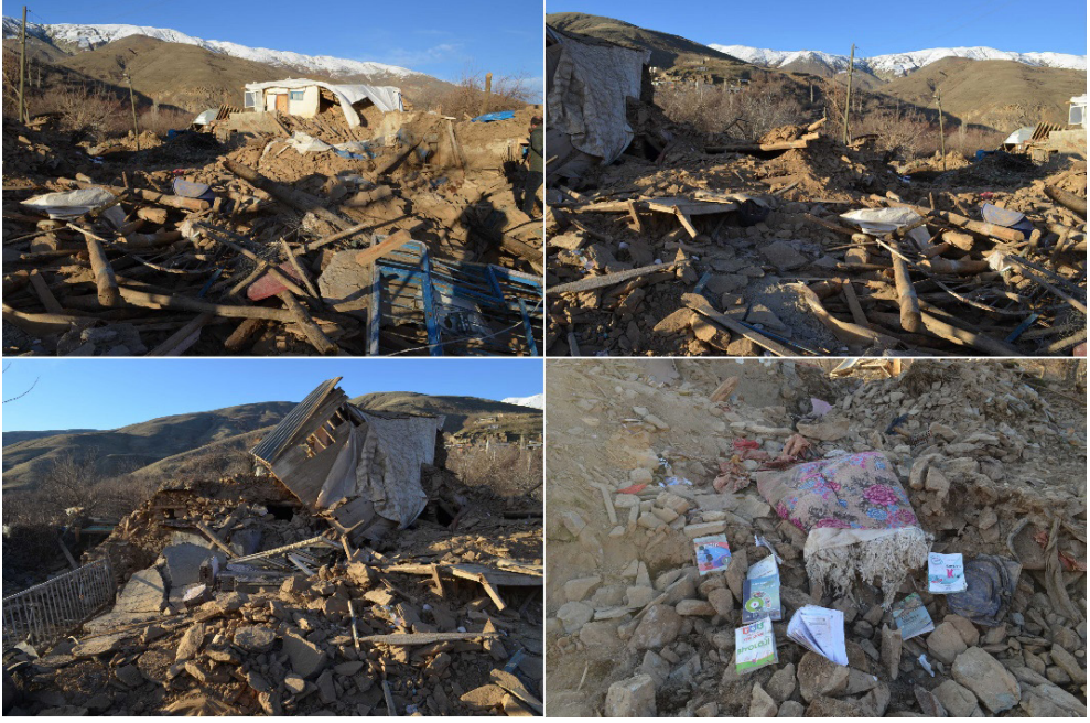
Şekil 28. Aşağı Çevrimtaş köyündeki yıkımlar.
