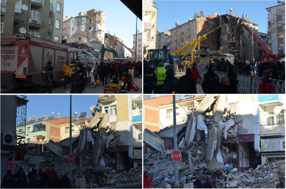
Şekil 24. Elazığ merkez Mustafapaşa Mahallesi'nde çöken binadaki enkaz kaldırma çalışmasına ait görüntü.
