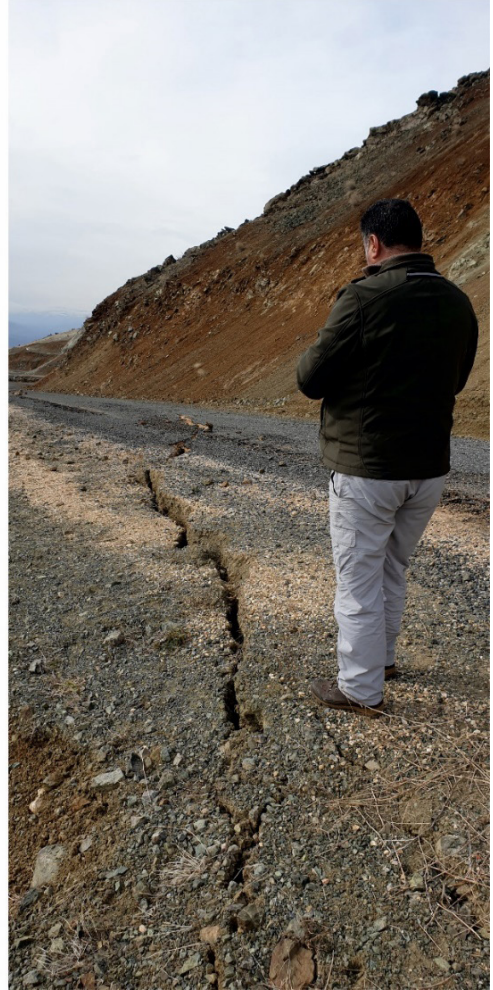
Şekil 12. Sivrice-Doğanbağı arasındaki yollar boyunca gelişen sismogravitasyonal yüzey deformasyonları
