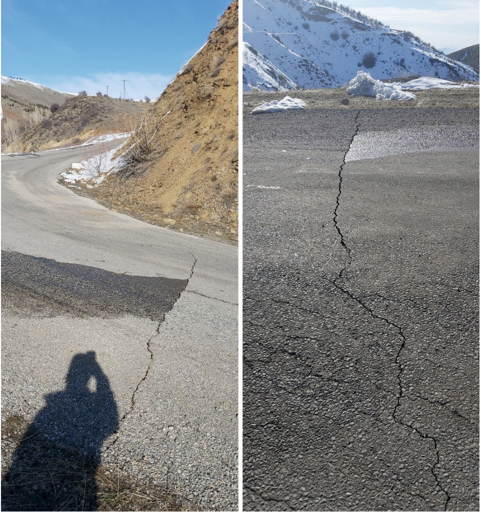
Şekil 16. Deprem sırasında gelişmiş olan kılcal çatlaklardan görüntüler
