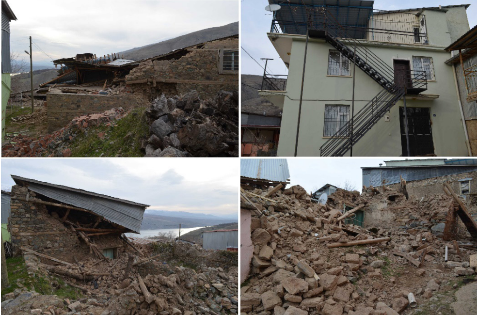
Şekil 26. Sivrice İlçesi'ne bağlı Doğanböl Köyü'nde meydana gelen hasarlar. Sağ üst köşedeki betonarme binanın hasar almadığına dikkat ediniz.
