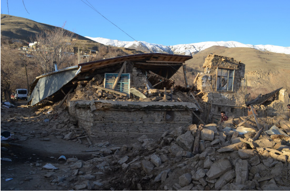
Şekil 29. Çevrimtaş Köyü'nde göçen ve yukarıda belirtilen özelliklere sahip bir konut.
