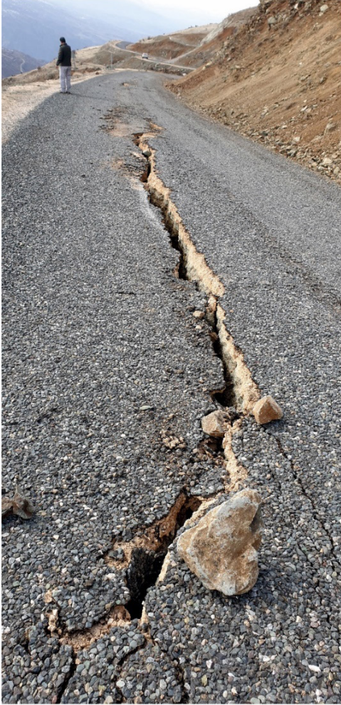
Şekil 12. Sivrice-Doğanbağı arasındaki yollar boyunca gelişen sismogravitasyonal yüzey deformasyonları
