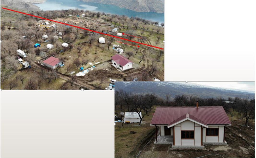
Şekil 2: Elazığ-Sivrice- Çevirimtaş Köyünde fay zonu üstüne yapılan konut
