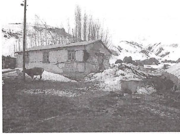
Şekil 3. Kızılçubuk köyünde dere ağzındaki birikinti konisi üzerinde yapılmış olan binadaki hasarlar
