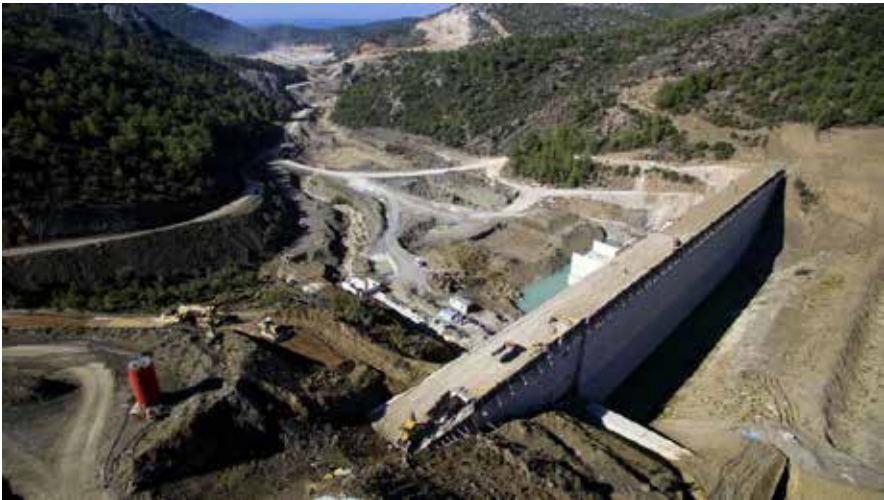
Şekil 12. Karareis Baraj inşaat evresi (İzmir).
