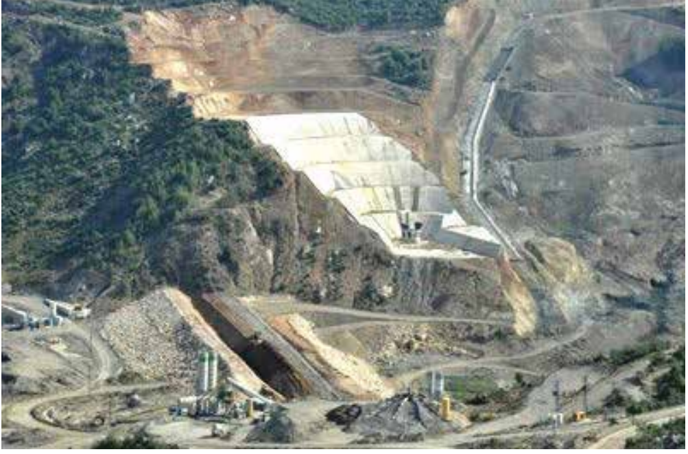
Şekil 11. Pamukluk Barajı inşaat evresi (Mersin).
