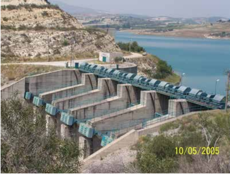
Şekil 8. Baraj Tesisi (Berdan Barajı, Tarsus).
