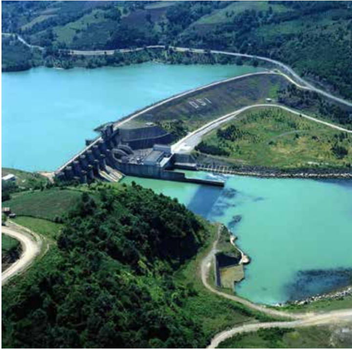
Şekil 9. Tamamlanmış bir baraj.
