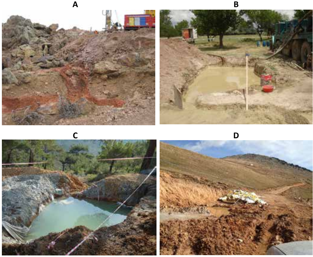
Şekil 4. Sondaj çalışmalarlarıyla ilgili kötü örnekler: A- sondaj yerinin hazırlanması, B- devir suyu, C- çamur havuzu ve D- terk edilmiş sondaj yeri.
