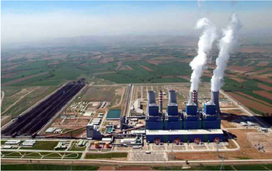
Şekil 7. Afşin-Elbistan Termik Santrali
