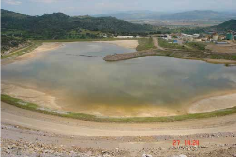
Şekil 7. Bir atık depolama tesisinin görünümü
