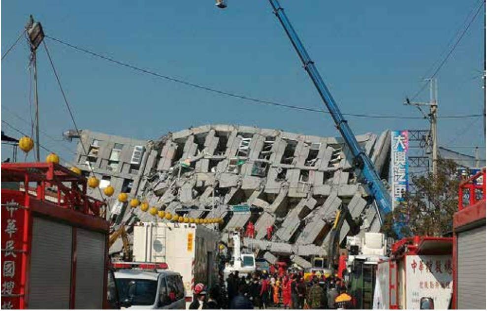
Yongkang bölgesinde 17 katlı binanın çökmesi sonucu 115 kişi hayatını kaybetti (koordinat: 23.005433°K 120.2603917°D)
