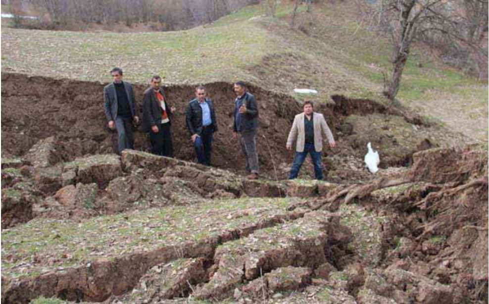
Heyelanın devasa gerilme çatlakları
