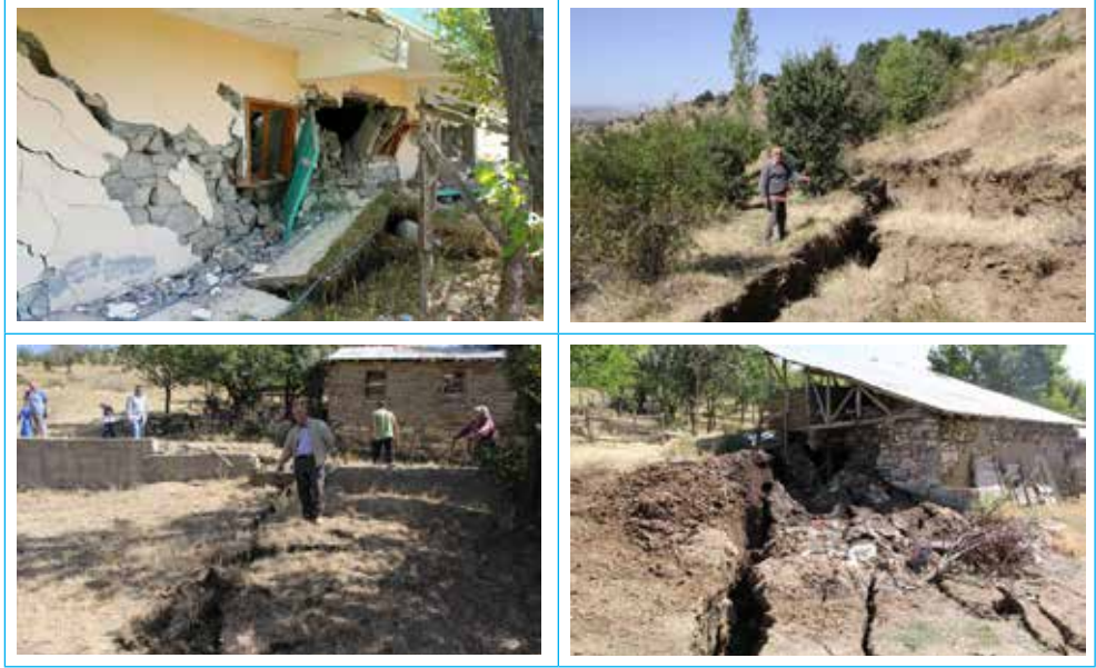
Heyelanın gerilme çatlaklarından ve hasar gören evlerden bazı görüntüler
