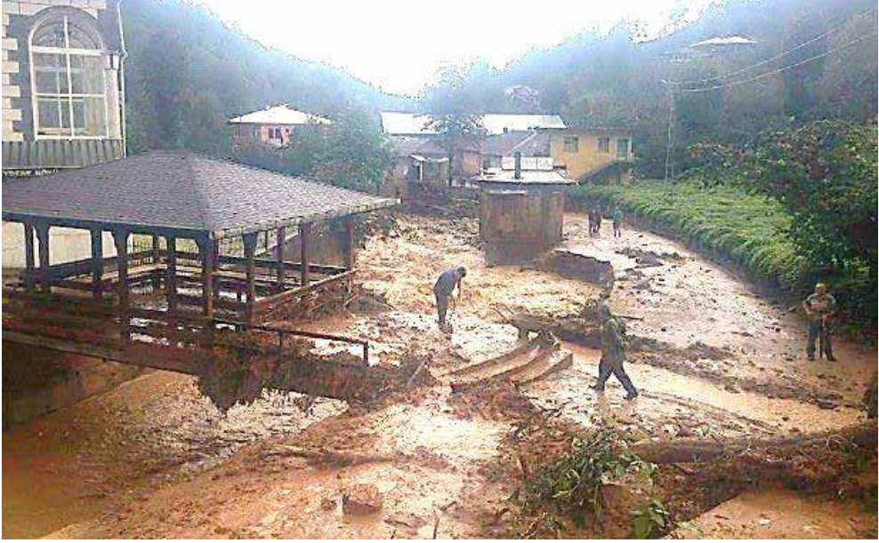
Selin ve heyelanın neden olduğu hasarlar
