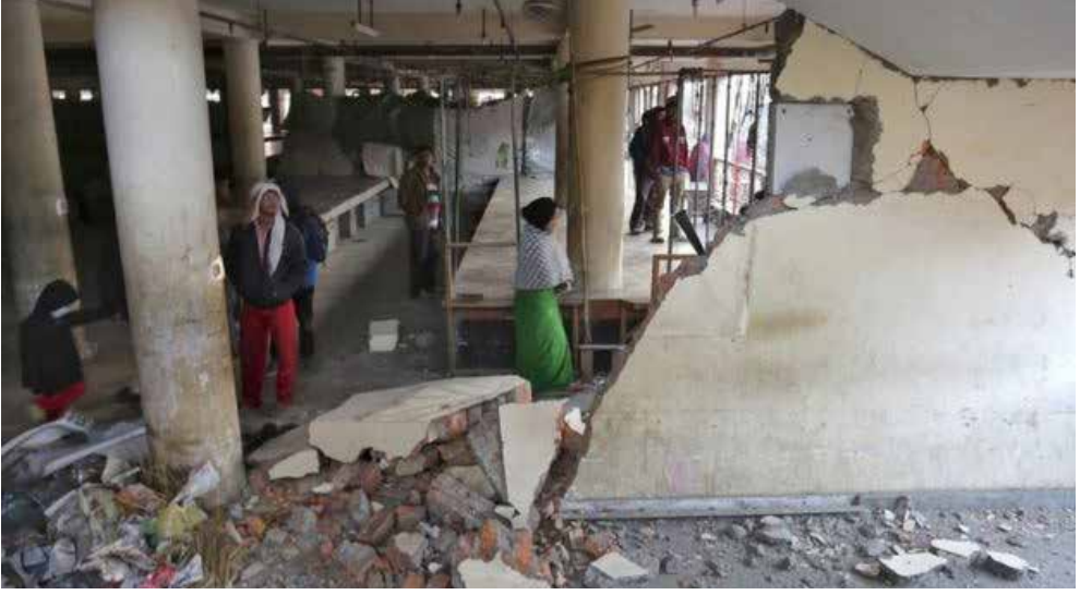
Sarsıntının yapısal hasara neden olduğu 6 katlı yeni yapılmış yapılardan biri (Kaynak: www.bbc.com/news/world-asia-india-35219069 )
