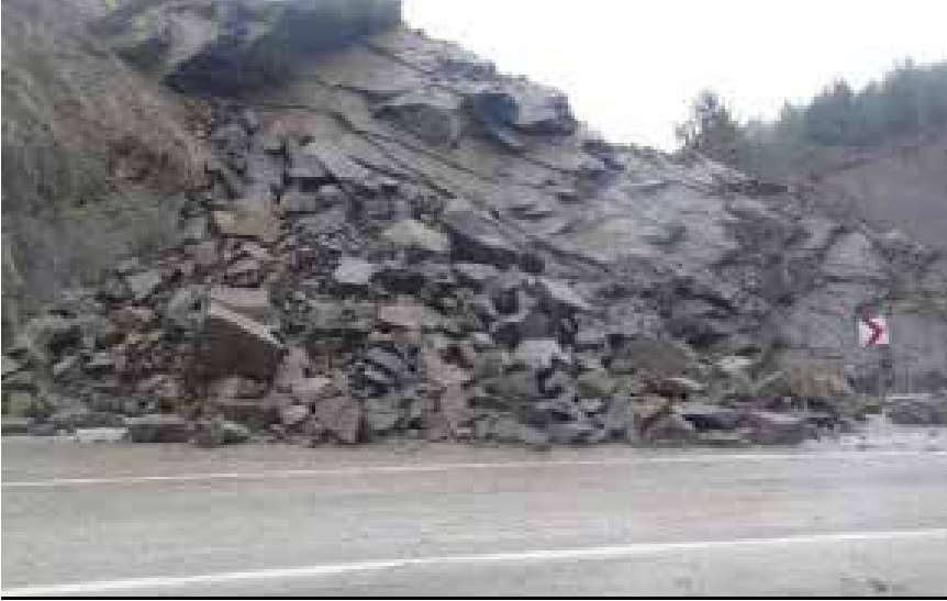
Tabakaların eğim yönünde kayarak karayoluna yuvarlanan kayalar
