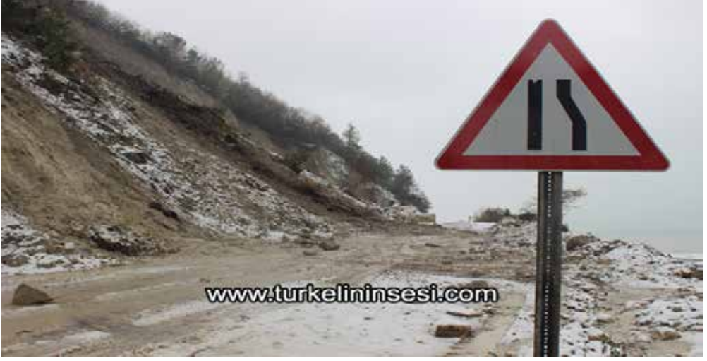
Heyelan nedeniyle kapanan yol tehlike devam ettiğinden kısmen temizlendi
