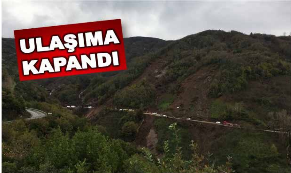
Heyelan nedeniyle kapanan yol
