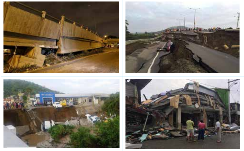
16 Nisan 2016 tarihinde Ekvador depremindeki Guayaquil'de çöken bir üst geçit, yol ve yassı kadayf gibi tamamiyle yıkılan binalar gösteren yapısal hasarlar (Kaynak: www.strangesounds.org/2016/04/devastating-earthquake-ecuador-pictures-videos-april-2016-233-dead.html )
