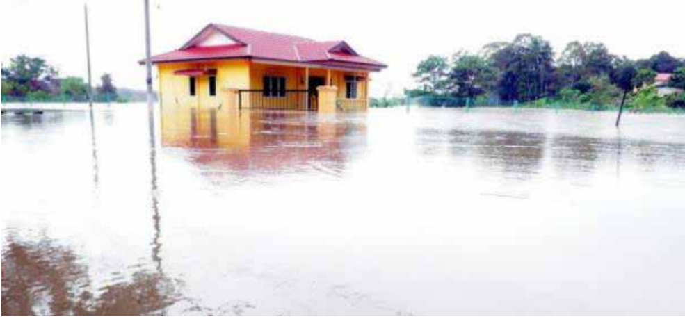
Sel suları ve sular altında kalan ev
