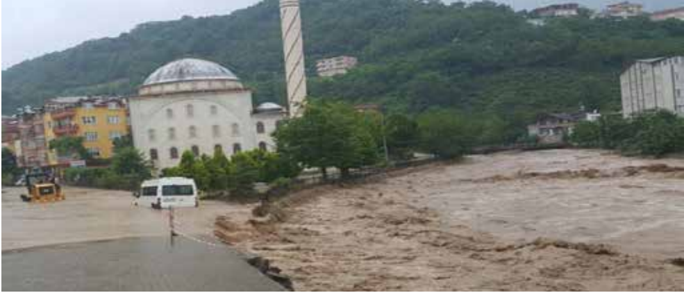
İlica Irmağı'nın suları sel nedeniyle yatağından dışarı ve büyük hasarlara neden oldu
