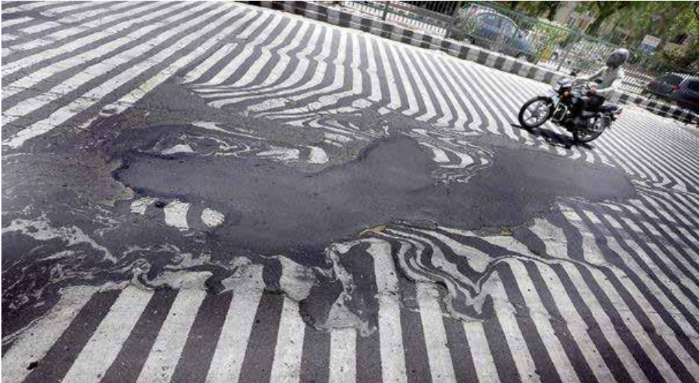
2015 yılında Hindistan'da aşırı sıcaklar nedeniyle 1400 kişi hayatını kaybetti. Resimde sıcaklar nedeniyle asfalt erimiş ve yol şeritleri akması sonucu şekil değiştirmiş (Resim: EPA/HARISH TYAG, Kaynak: www.telegraph.co.uk/news/worldnews/asia/india/11636124/Indias-extreme-heat-wave-in-pictures.html )
