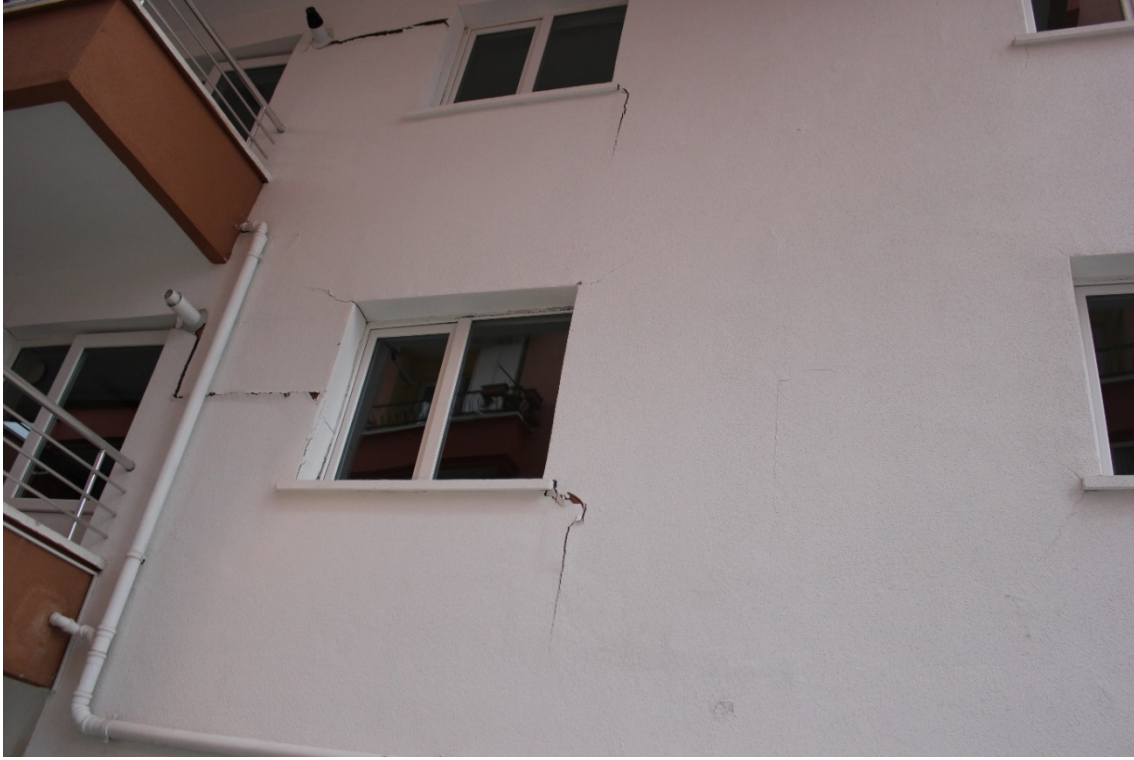
Şekil 7. Zeminde, bahçe ve apartman duvarlarında oluşan çatlaklar
