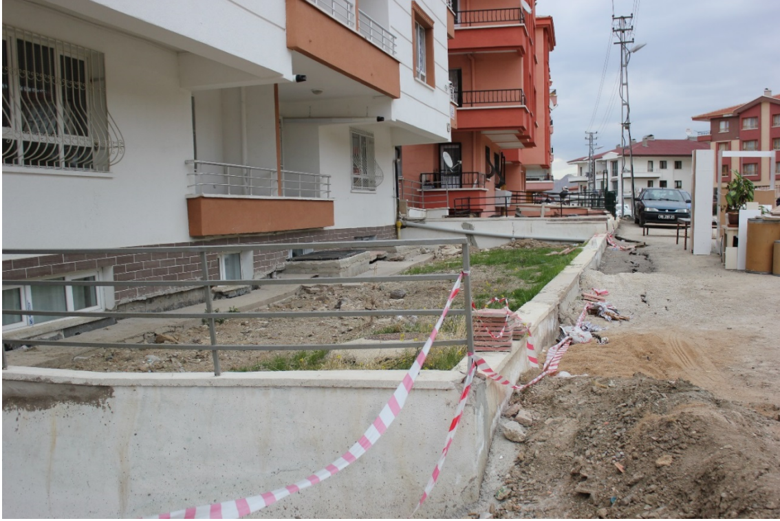
Şekil 5. 7 Nolu Ata Ap. Önündeki kopma aynası
