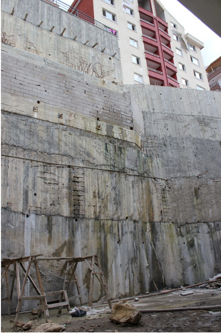
Şekil 11. İstinat duvarlarındaki nemlenmeler ve barbakanlar.
