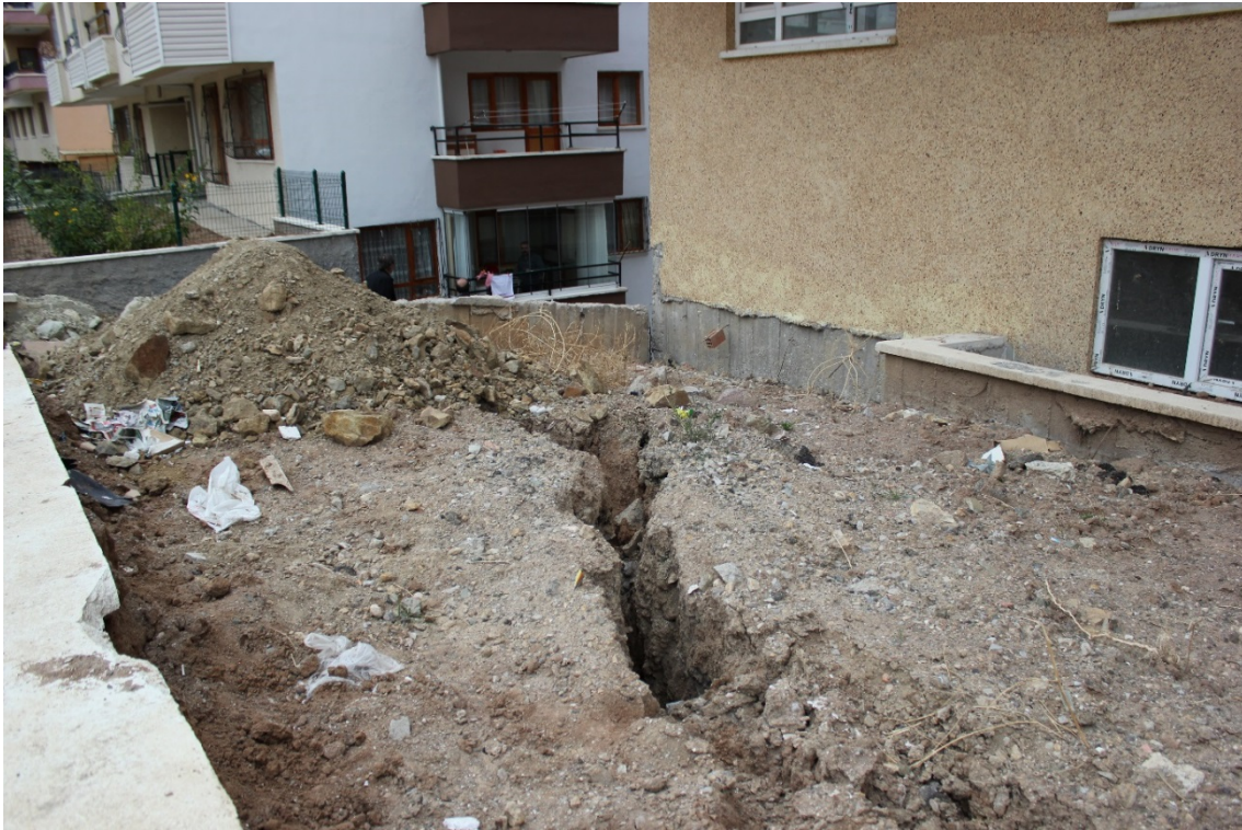
Şekil 6. 5 Nolu Apartman önündeki önündeki kopma aynası
