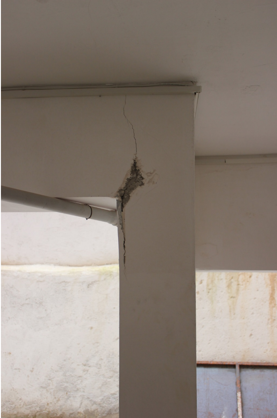
Şekil 8. 7 nolu Ata Apt. Taşıyıcı kolonlarında da önemli çatlaklar
