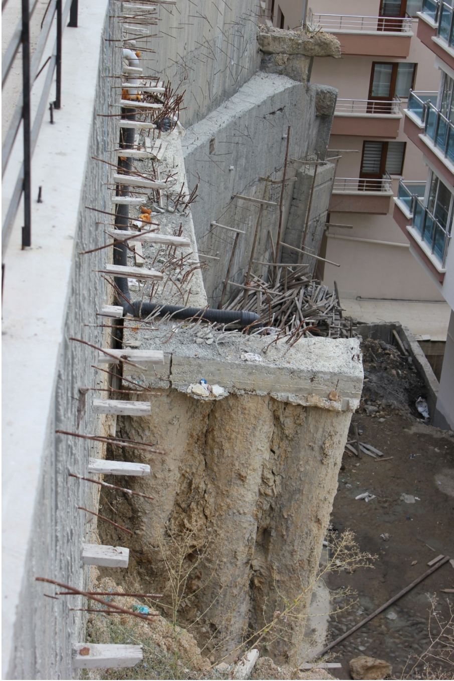
Şekil 12. İstinat duvarlarının birbirinden bağımsız çalıştığıın bir göstergesi olan alt ve üst taraftaki istinatlar arasındaki açılmalar ve forekazıklardaki eğilmeler.
