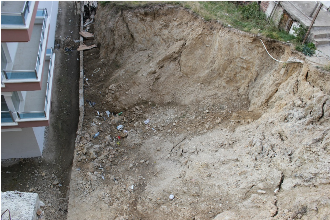
Şekil 3. Tamamen bozunmuş (W5), toprak haline gelmiş grovıklardan görünüm
