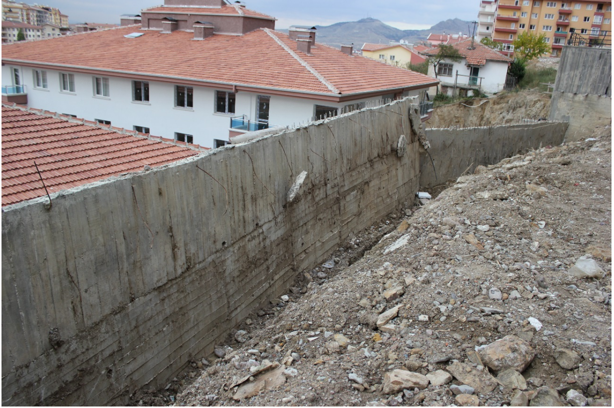
Şekil 4. Apartmanların arka bahçelerinde gözlenen dolgu malzemesi
