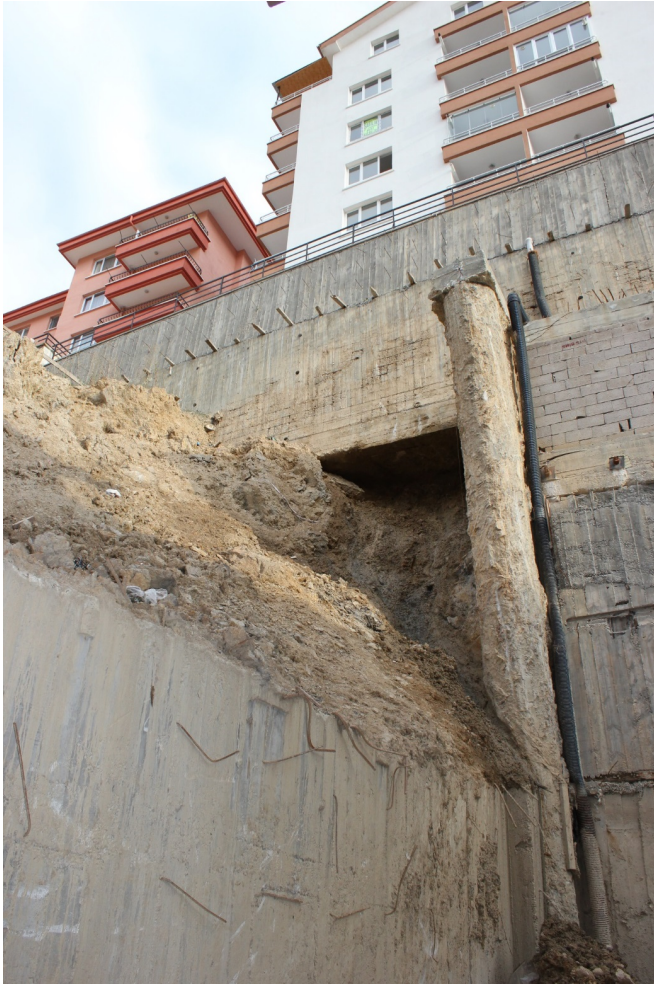
Şekil 10. İstinat duvarları altından su çıkışı
