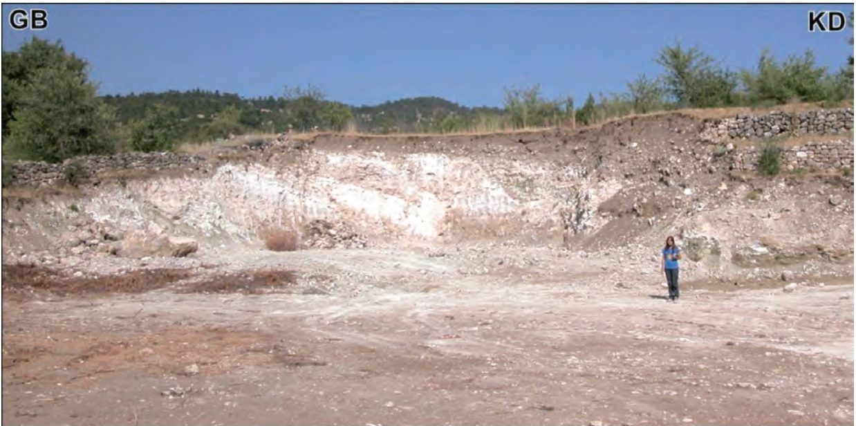
Şekil 13. Çameli'nin güneyinde, Çameli Fayı önündeki kuzeybatıya tiltlenmiş kil, silt, yamaç molozlarının deforme kesimlerinden bir görünüm (Elitez, 2010) (Koordinat: 37°4'0.00''K 29°20'39.30''D).
