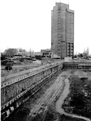
Dışişleri Bakanlığı Ek Binası Fore Kazık ve Ankrajları
