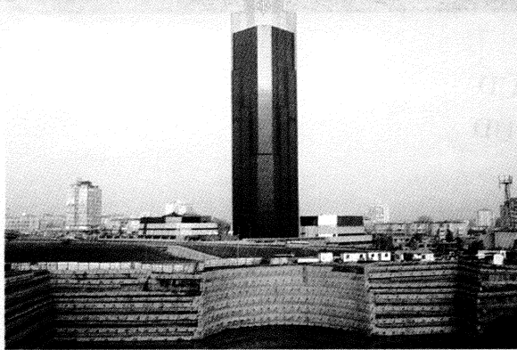
İş Bankası Genel Müdürlük Binası Ankrajları
