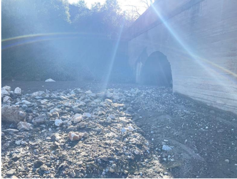
Şekil. TCDD Alt Geçidi (Yaklaşık 150 cm dolgu yüksekliği bulunuyor)
