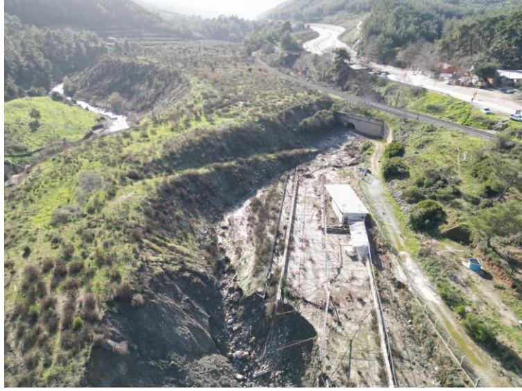
Şekil. Vatandaş Arazisi – TCDD Alt Geçidi- Yıkılan Yol (Güzergâh GD-KB)
