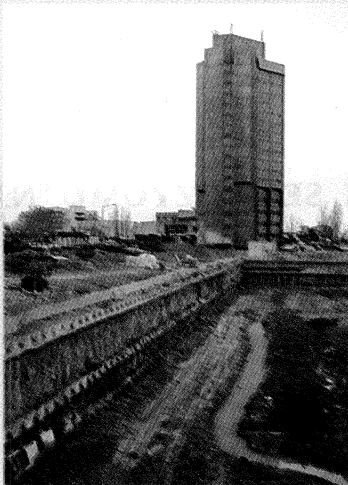
Dışişleri Bakanlığı Ek Binası Fore Kazık ve Ankrajları
