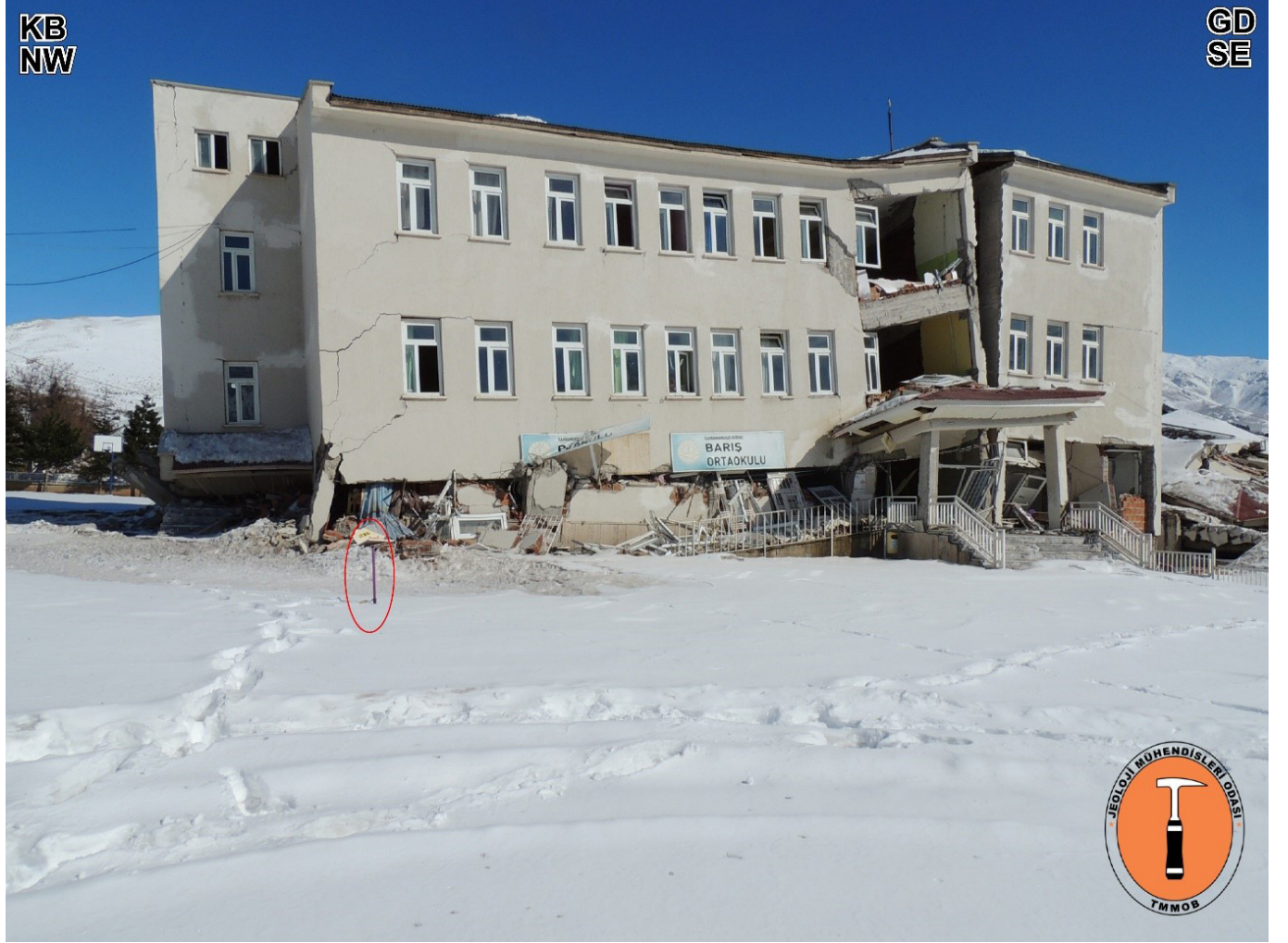
Şekil 5: Kahramanmaraş ili, Nurhak İlçesi, Barış Beldesi, Barış Ortaokulu
