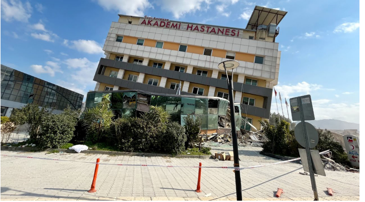
Hatay Merkez Akademi Hastanesi Binası
