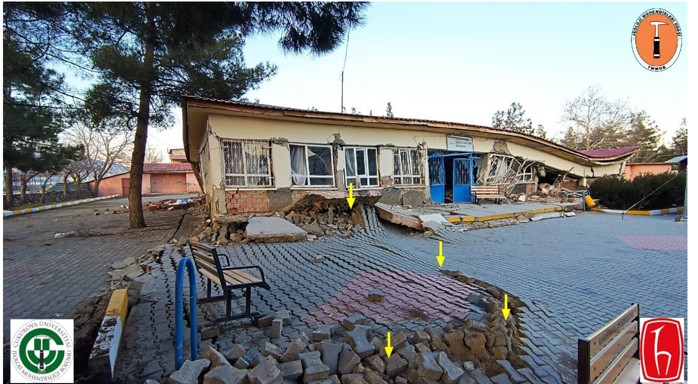
Şekil 6: Kahramanmaraş ili, Türkoğlu İlçesi, Şekeroba Beldesi, Yunus Emre Ortaokulu
