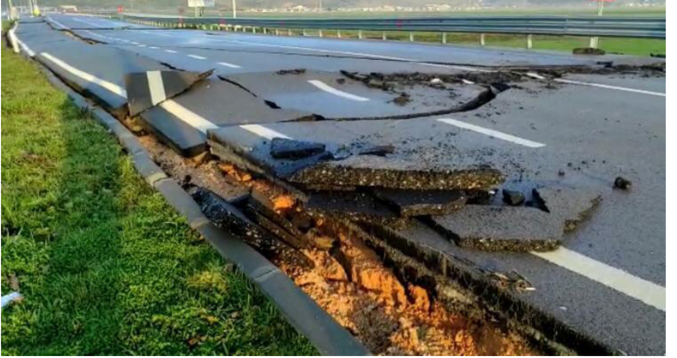
Şekil 6-7-8: Hatay Havaalanı Pist Yolu
