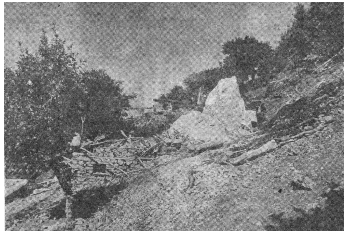
Şekil 11. Yamaçlı'da depremde yandaki yamaçtan koparak yuvarlanmış ve bir evin 2 odasını kaplamış kayalar.
