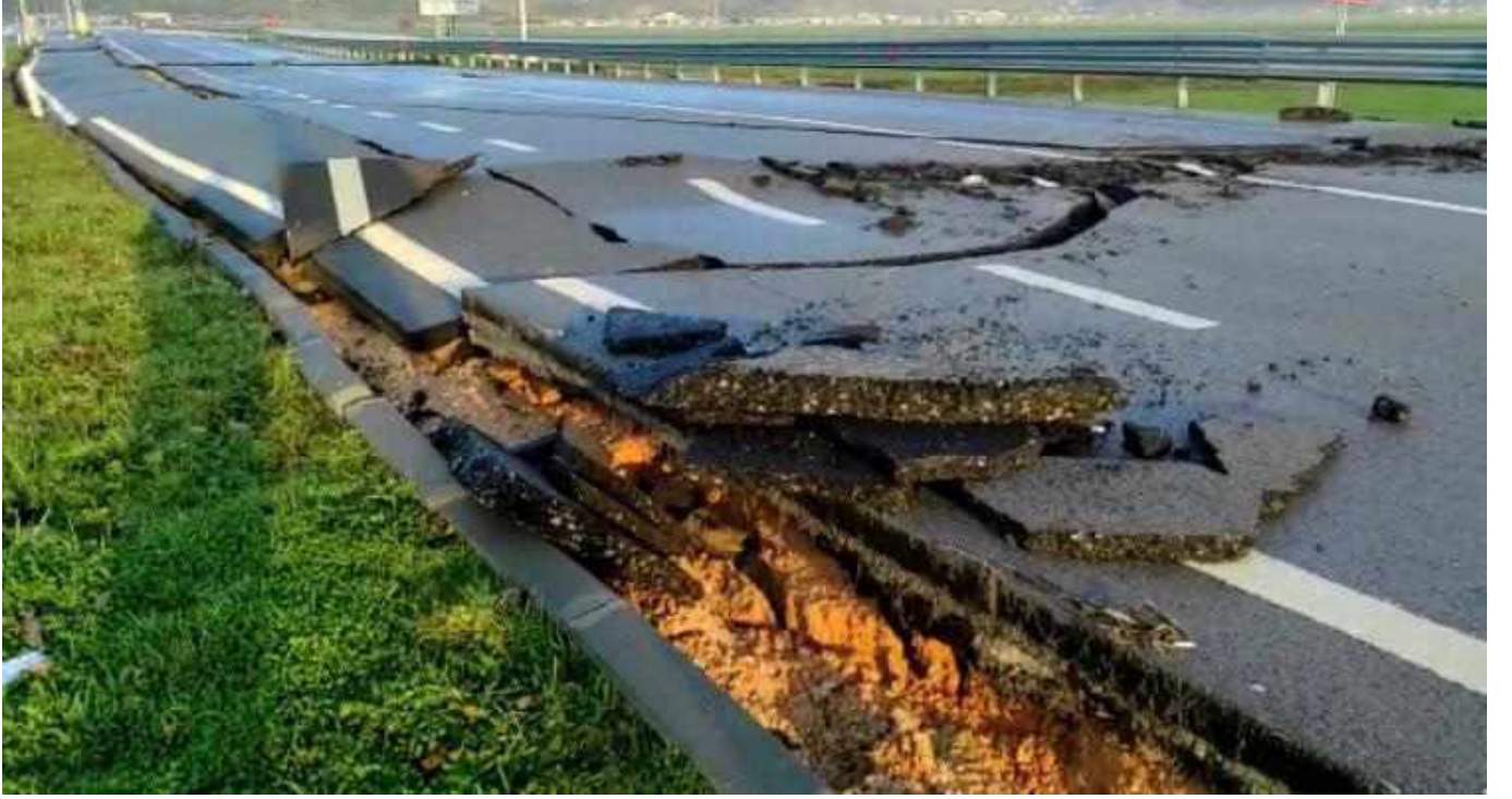
Şekil 6-7-8: Hatay Havaalanı Pist Yolu
