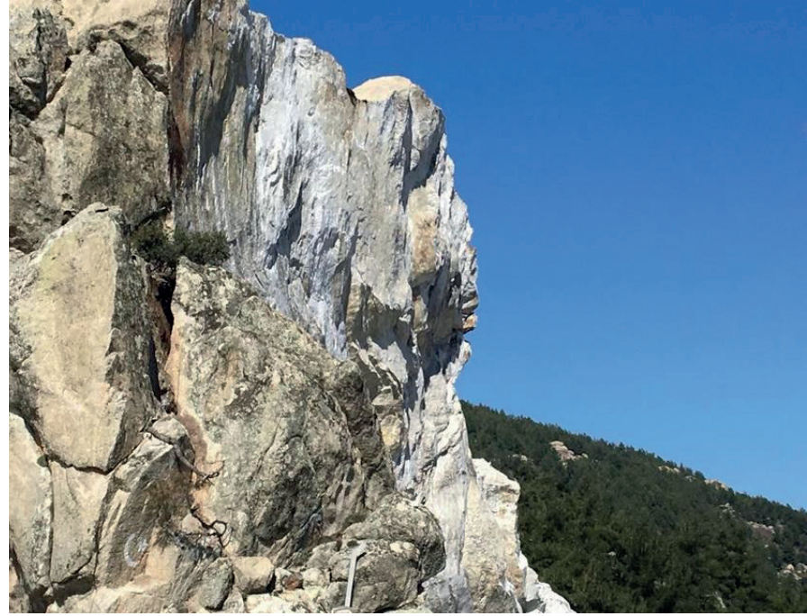
Şekil 4: Bölgede gözlemlenen kayalardaki kırıklı, çatlaklı yapı
