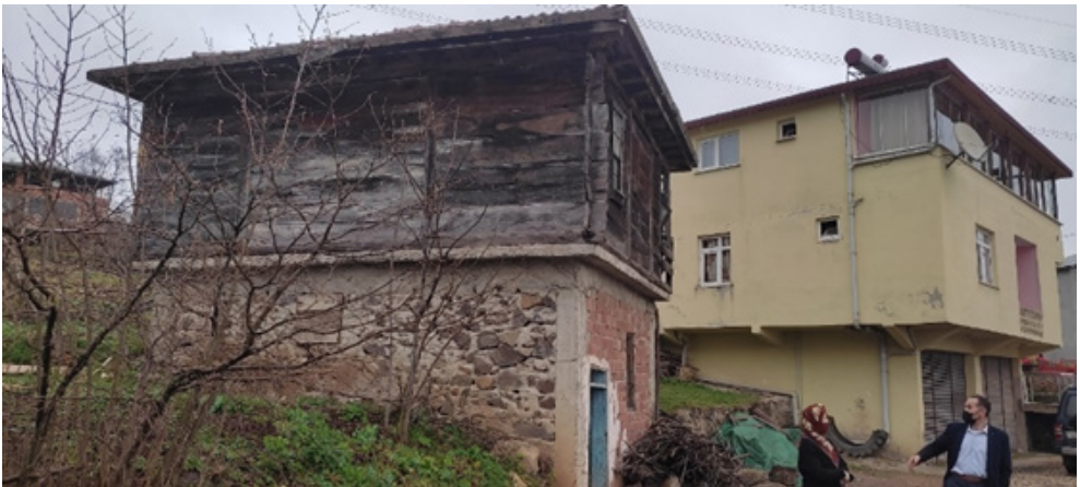
Şekil 5. 2. Maksutlu mevkiinde arazi yapısı, yamaç ve yapıların durumu.
