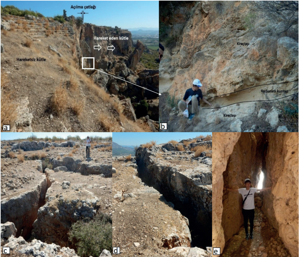
Şekil 3. a) Antik kentin GD yamacında meydana gelmiş devrilmeler ve açılma çatlığı, b) kireçtaşı içinde yer alan karbonatlı bozunmuş kumtaşı seviyesinin görünümü, c) antik kentin KB kenarında birbirini kesen açılma çatlakları, d) 1.2m'lik düşey yerdeğiştirme, e) KB yamacı tabanında genişliği 0.8m –1.8m arasında değişen çatlakın görünümü.
