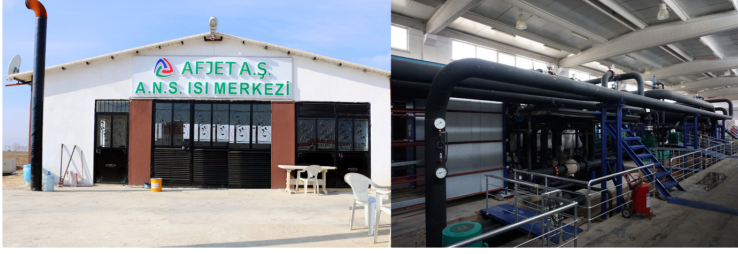
Şekil 7. Afyon şehir ısıtması (AFJET'ten alınmıştır)
