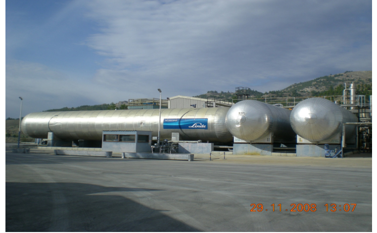
Şekil 11. Kızıldere sahasında yan ürün olarak sıvı CO 2 üretimi
