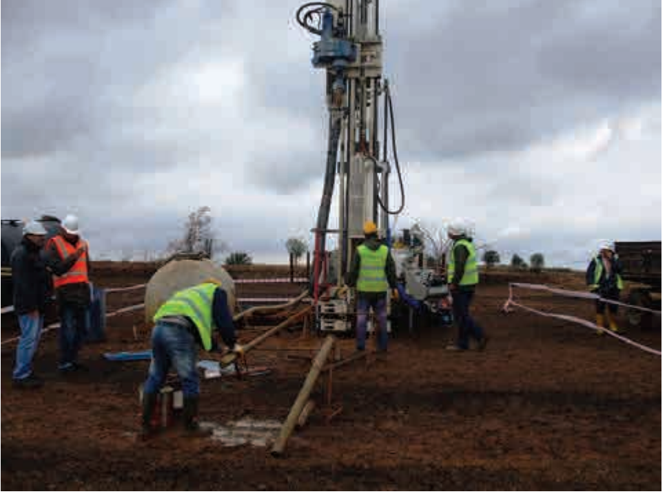
Fotoğraf 2: İSG kurallarına uygun, çevreci ve teknolojik makinelerin jeoteknik arařtırmalarda kullanılması (Çorlu-Tekirdağ, Geoteknik A.Ş. 2011)
