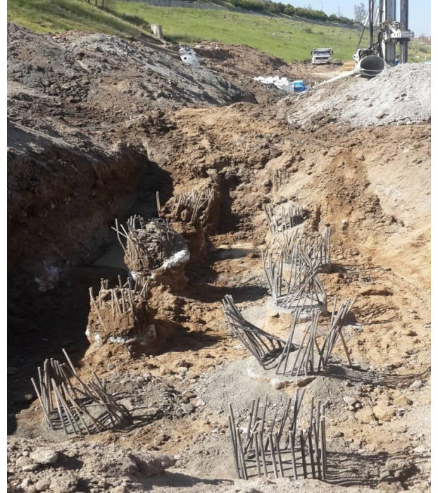
Şekil-6 TOKİ İlköğretim Okuluyla, heyelan tacında yer alan 8809/11 sokak arasında yapılan kazık çalışmaları. Sokak çitindeki deformasyonlar ve yeni dökülen asfalt üzerinde izlenen çatlaklar.
