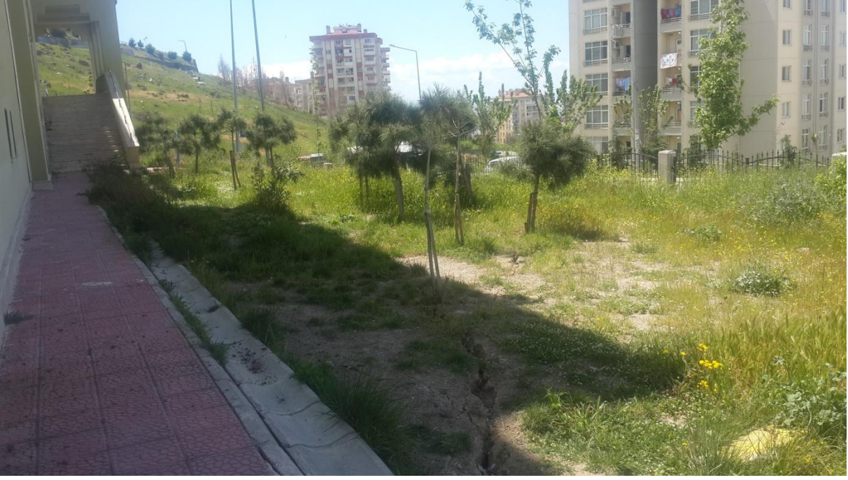
Şekil-4 TOKİ İlköğretim Okulu bahçesinde zeminde bina temeline doğru ilerleyen tansiyon çatlakları
