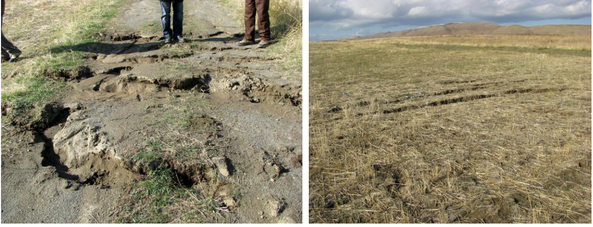
Şekil 27. Van Merkez Alaköy arazilerinde görülen sıvılaşma (A) ve oturma yapılarına (B) örnekler.
