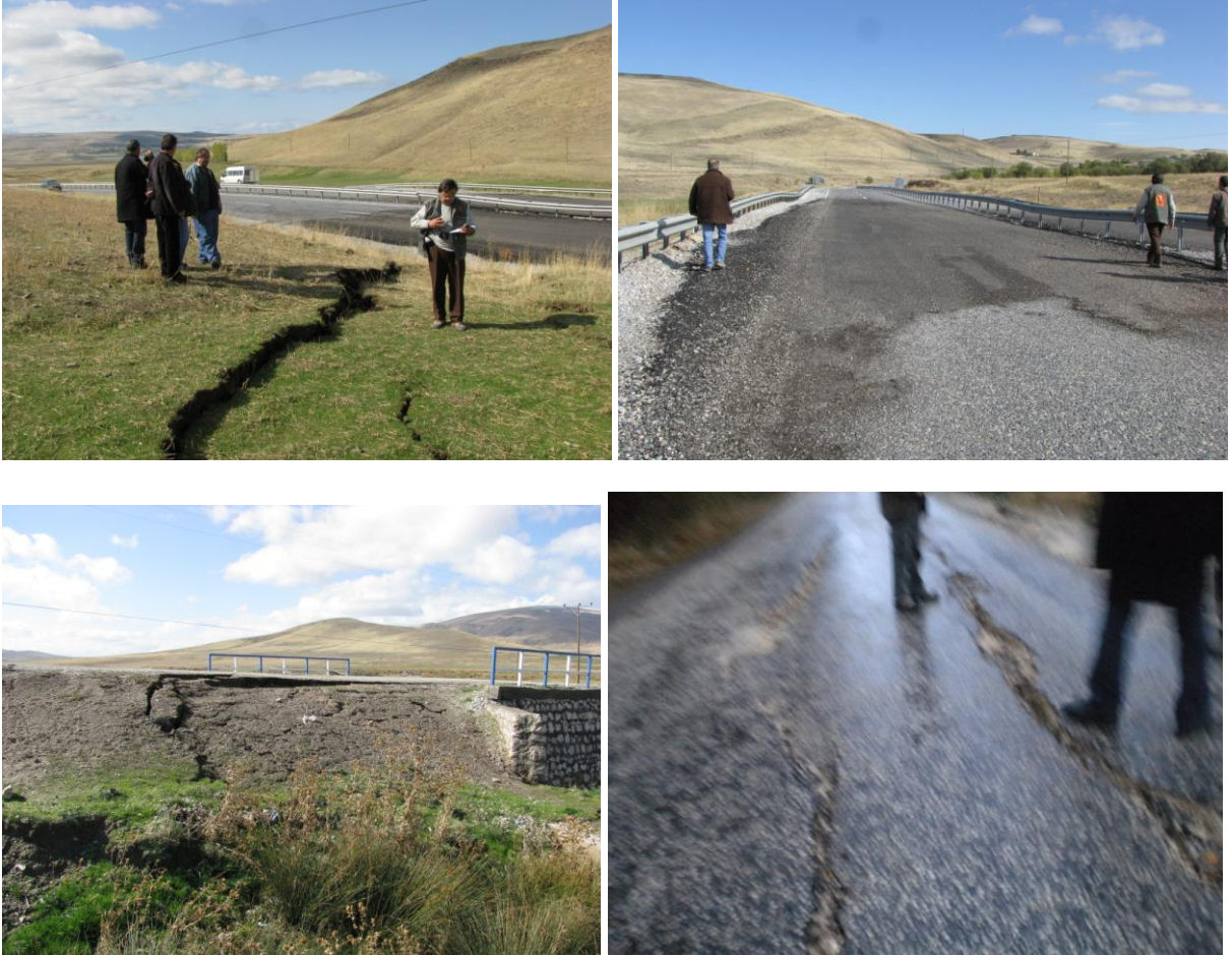
řekil 35. Van-Erciř karayolunun yamacında meydana gelen heyelan (sol üst), bu heyelanının yolda meydana getirdiđi deformasyonun tamir edilmiř hali (sađ üst), Göllü köyü yolu üzerinde meydana gelen deformasyonların menfez (sađ alt) ve yol üzerinde oluşturduđu deformasyon (sol alt).
