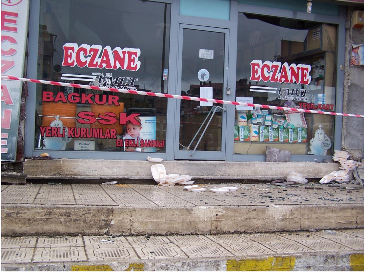
Şekil 15. Erciř ilçesindeki zeminde gözlenen oturma yapıları nedeniyle binalarda gelişen hasarlar. Yerdeki oturma nedeniyle kaldırım ile bina temeli arasında 5 cm lik bir kot farkı oluşmuştur.
