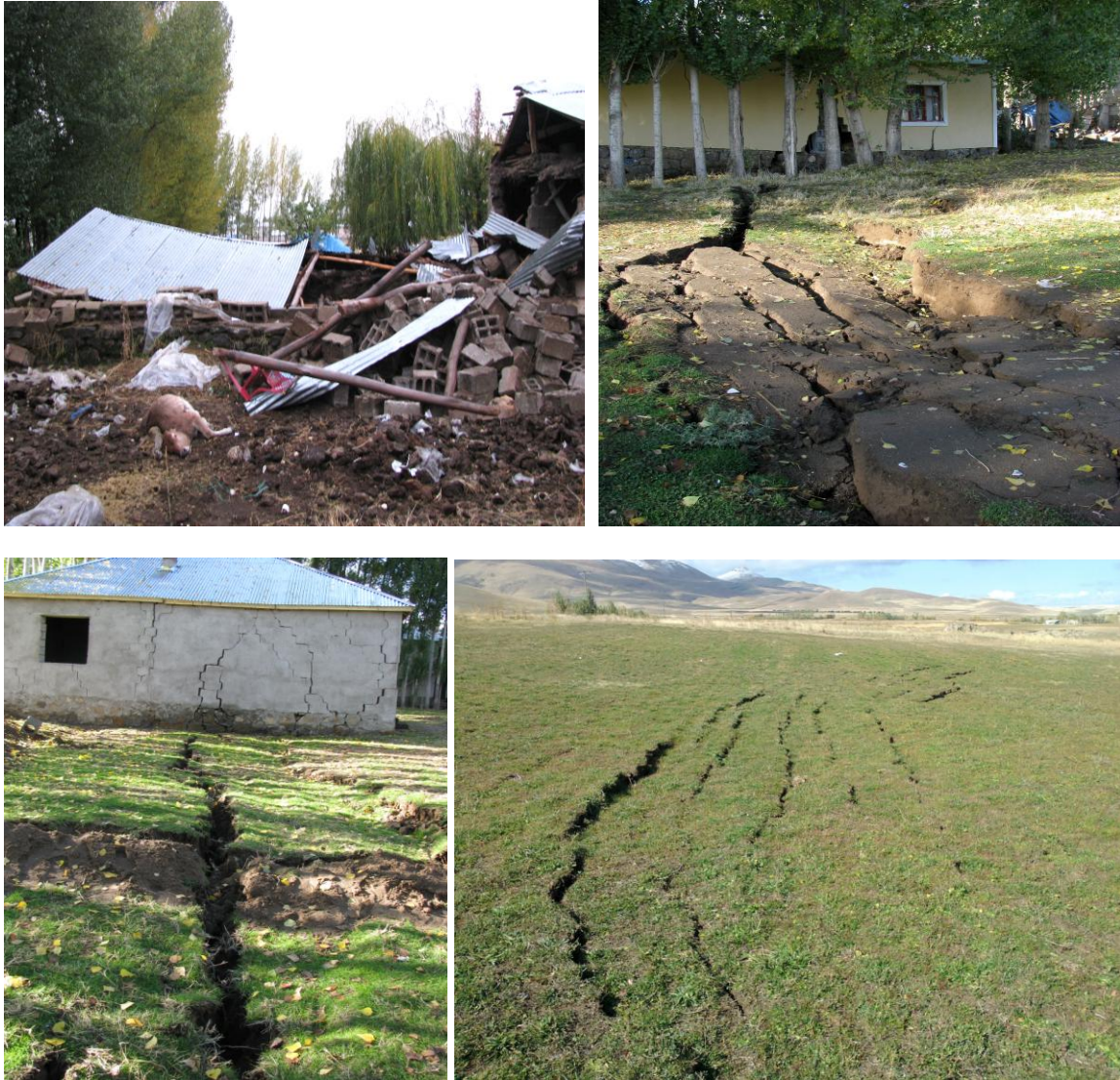
Şekil 31. Erciş-Çelebibağ beldesinde yıkılan hayvan barınağı (sol üstte), yanal yayılmanın yapı üzerinde neden olduğu hasar ve deformasyon (sağ üst ve sol alt), deprem sonucunda oluşan yanal yayılma ve heyelanları (sağ alt) gösteren arazi görüntüleri.
