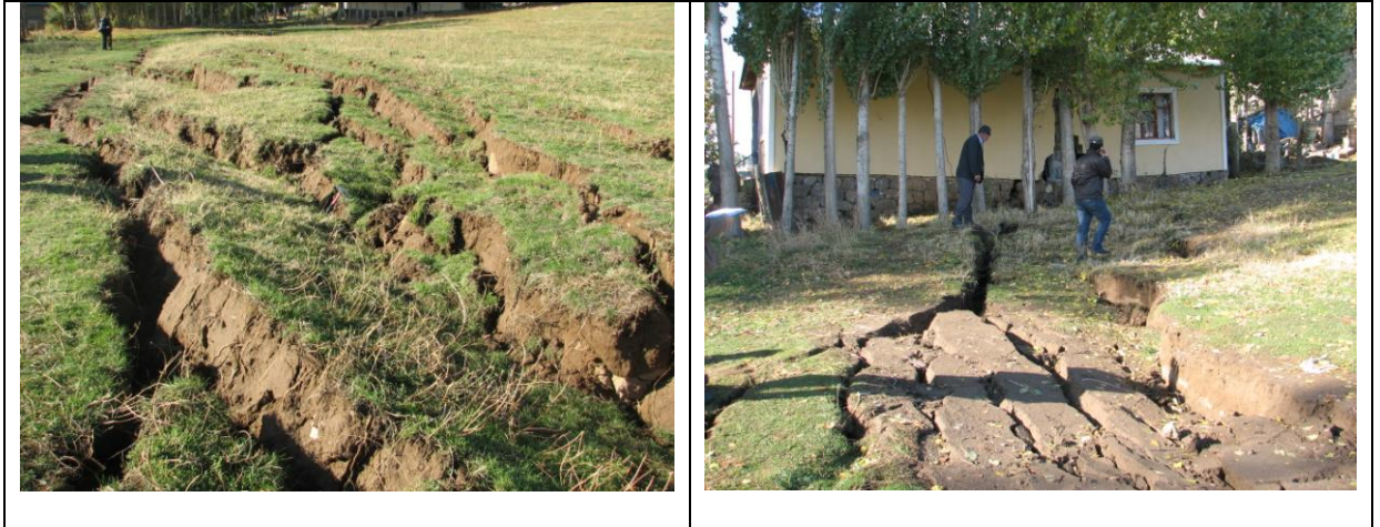
Şekil 10. Çelebibaği Mevkii kuzeyinde (L1a) gelişen heyelan/yanal yayılmayı gösteren arazi fotoğrafları. Çatlaklar arasında kalan blokların çatlak yüzeylerine ters yönde eğimlendiğine (geriye doğru çarpılma) dikkat ediniz.
