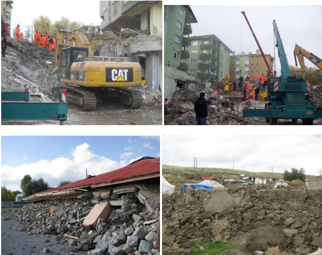
Şekil 36. Erciş'te enkaz kaldırma çalışması (sol üste), Erciş'te arama kurtarma çalışmaları (sağ üst), yıkılan Alaköy İlköğretim Okulu laboratuvar binası (sol alt), Dibekdüzü köyünde kaldırılmamış enkazlar (sağ alt).
