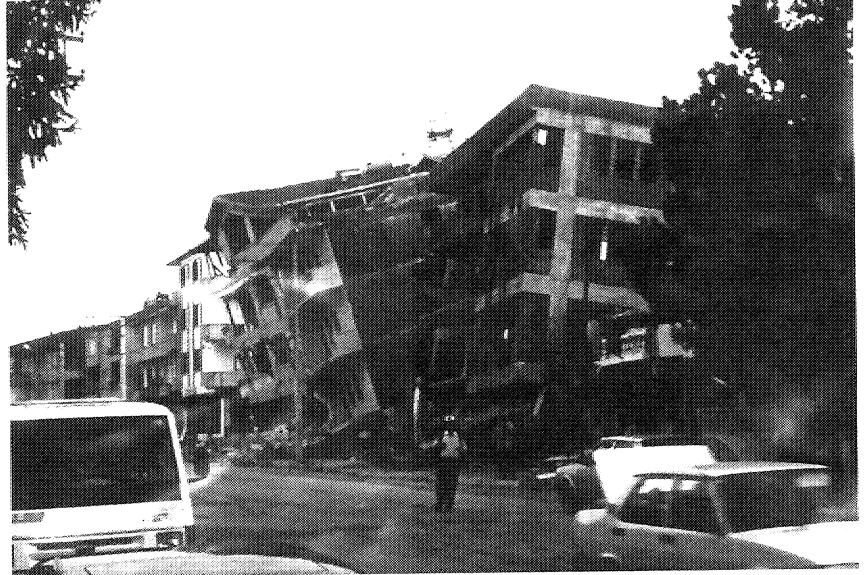
Akyazı Beidesi'nde, iki komşu binanın zemin koşullarına bağlı ayrı yönlerde yatması
