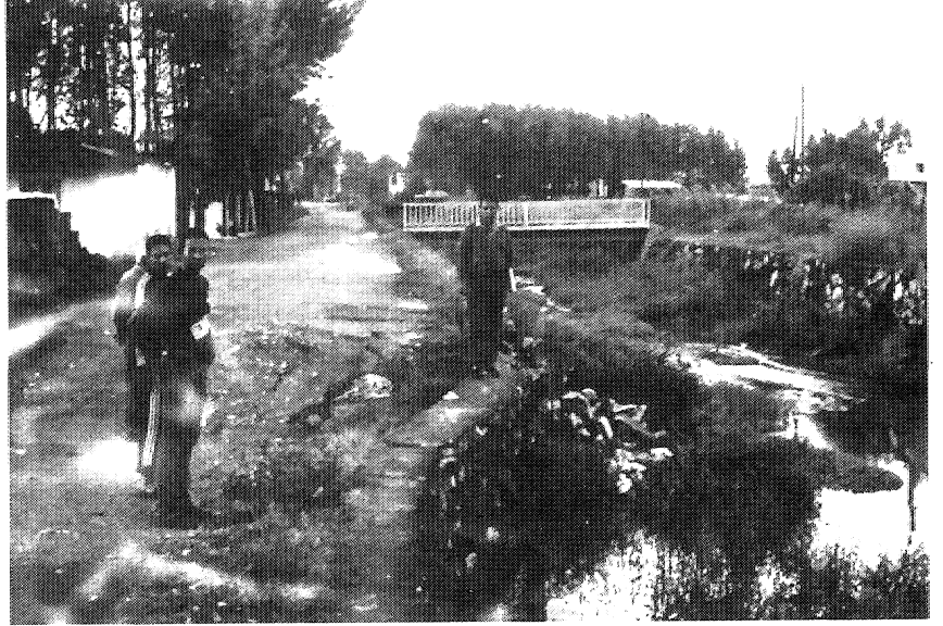
Aşağı Yuvacık Beldesi'nde, fay tarafından kesilip ötelenen dere duvarı
