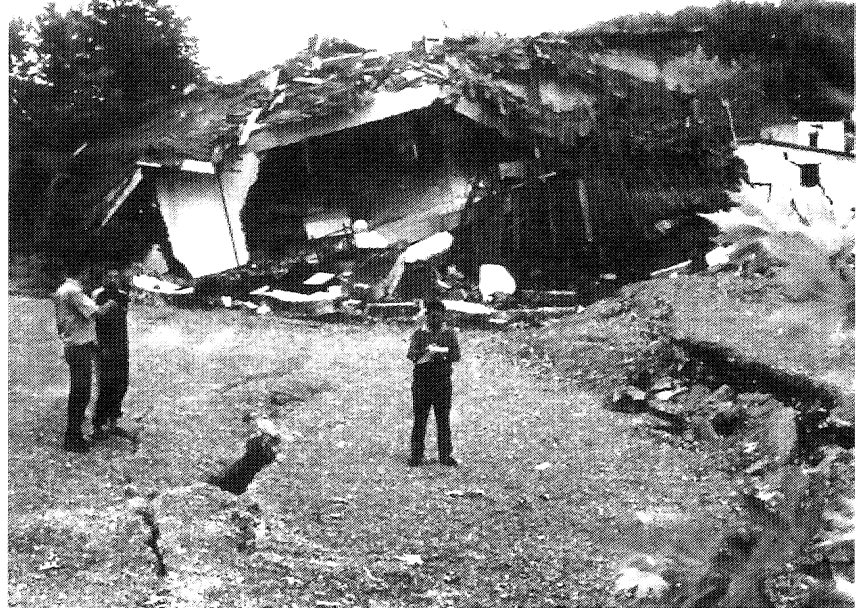
Aşağı Yuvacık Beldesi'nde, fay zonu üzerindeki ilköğretim okulunda hasar
