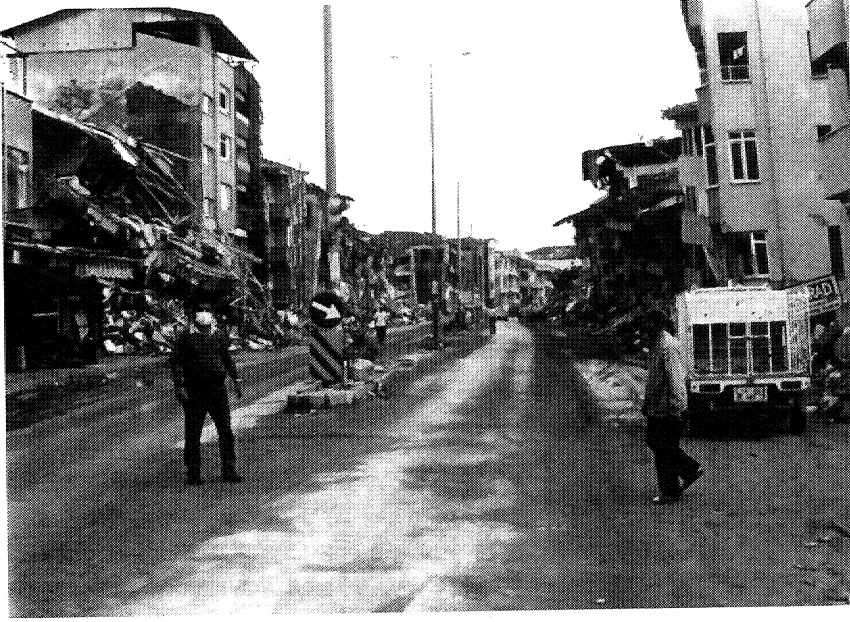
Adapazarı'nda, sulu ve gevşek zemin üzerindeki bina hasarları
