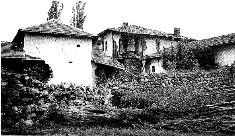
Şekil 13. Orta depreminde çamur harçlı moloz taş duvarlı ve kerpiç duvarlı yapılarda gözlenen tipik yapısal hasarlardan genel bir görünüm.
