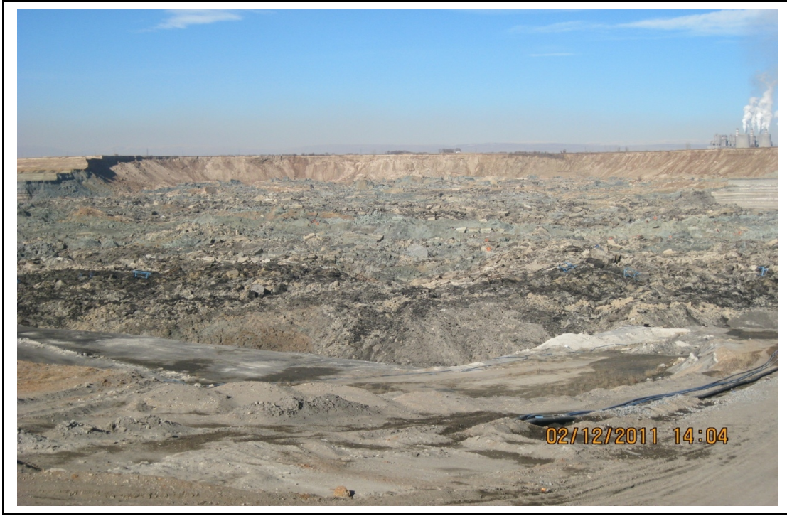
Şekil 4. Doğu şevindeki heyelandan ve kayan malzemedeki görünüm
