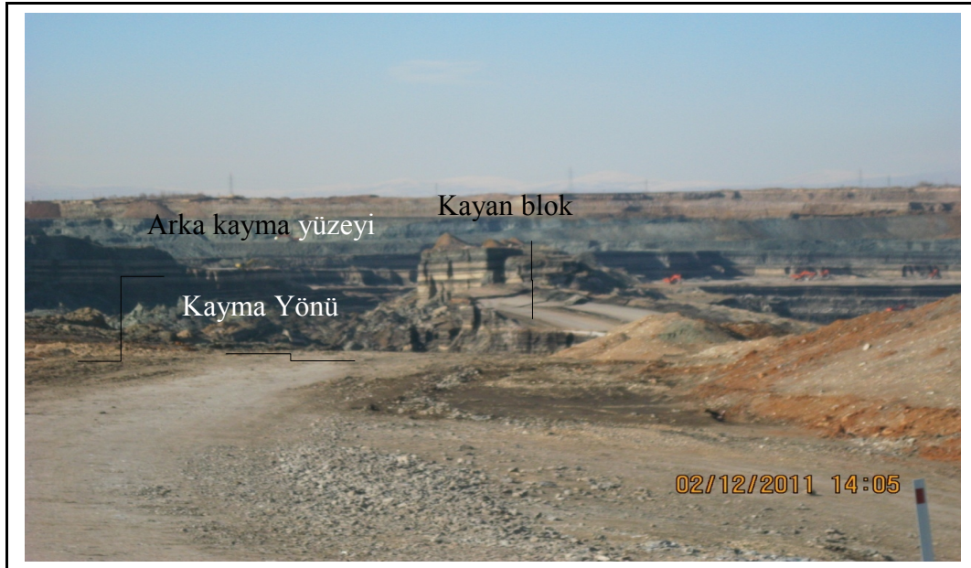
Şekil 3. Aktif-pasif bloklı kayma modeli ve Çöllolar sahasındaki ilk kaymanın görünümü
