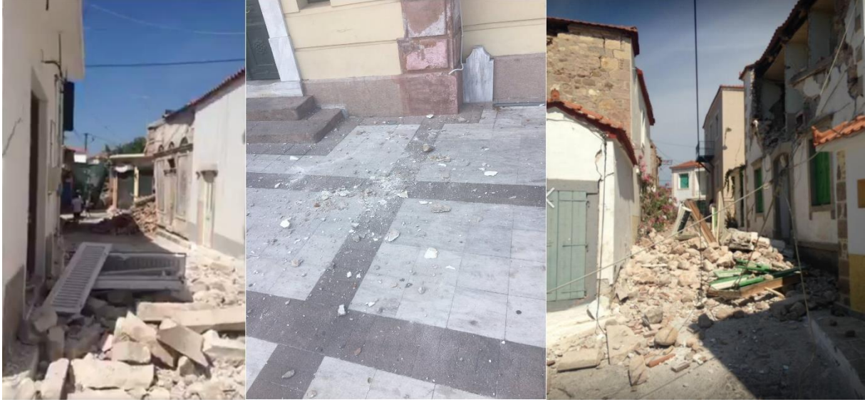
Şekil 2. Mw: 6.2 büyüklüğünde meydana gelen deprem sonrası Lesbos' da bulunan Vrisa kasabesindeki hasar görmüş yapılara ait görüntüler ( www.thesun.co.uk ).
