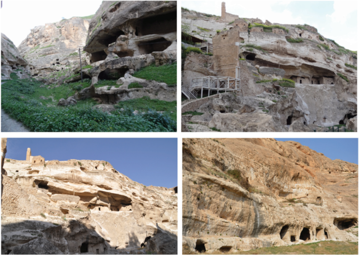
Şekil 5. Hasankeyf kaya meskenleri Hoya Formasyonu'nun üst kesimlerini oluşturan nispeten yataya yakın tabakalı, erime boşluklu, üste doğru evaporit miktarı artan, tebeşirli, travertenimsi karbonatlara oyularak yapılmıştır. Bu kayalar dayanıklı, masif ancak kolay işlenebilir özelliktedir.
