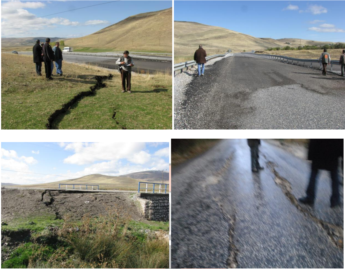
Şekil 35. Van-Erciş karayolunun yamacında meydana gelen heyelan (sol üst), bu heyelanının yolda meydana getirdiği deformasyonun tamir edilmiş hali (sağ üst), Göllü köyü yolu üzerinde meydana gelen deformasyonların menfez (sağ alt) ve yol üzerinde oluşturduğu deformasyon (sol alt).
