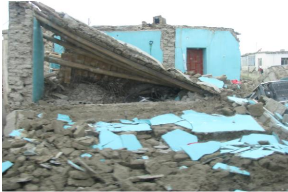
Şekil 33. Alaköy ve Mollakasım köylerinde göçen yukarıda belirtilen özelliklere sahip konutlar.
